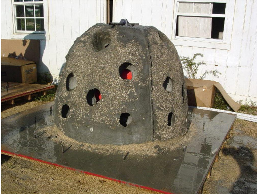
Abb. 13: Beispiel eines Reefballs (Photo T. Meyer, Marilim)
